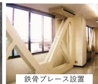
下水処理場の耐震化
