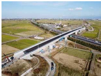
新潟中央環状道路 (くろさき茶豆大橋)
