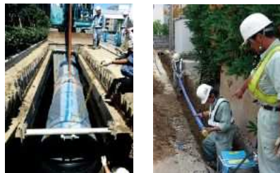
耐震管への更新工事
