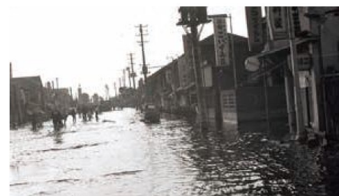
新潟地震による津波浸水被害
