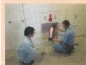
消防設備点検
