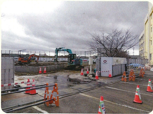
基礎工事が始まったグラウンド (2023年12月撮影)
