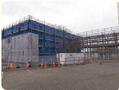
建方工事の様子 (2024年1月撮影)
