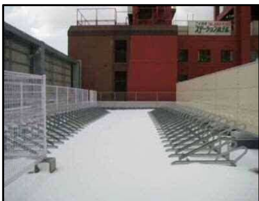
【写真5】屋上駐輪場①
