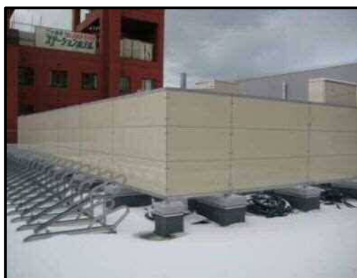
【写真8】屋上遮音壁
