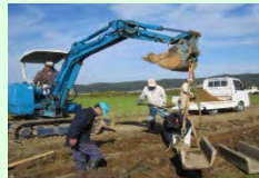
コンクリート水路の更新
