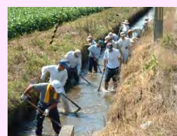
水路の泥上げ
