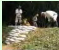
漏水箇所の補修
