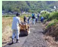
未舗装農道の舗装
