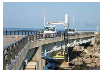
獅子ヶ鼻大橋点検の状況
