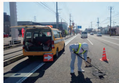
舗装補修の状況
