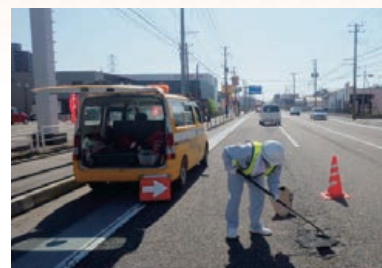
舗装補修の状況
