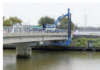
親松あやめ橋点検の状況
