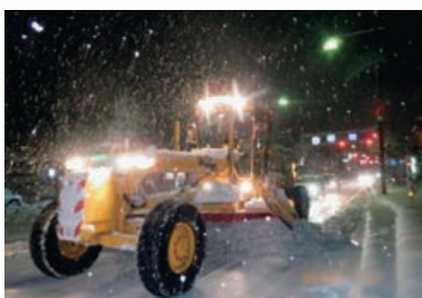
車道除雪の状況
