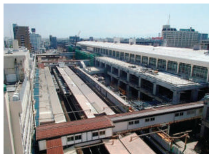
新潟駅部での高架橋工事
