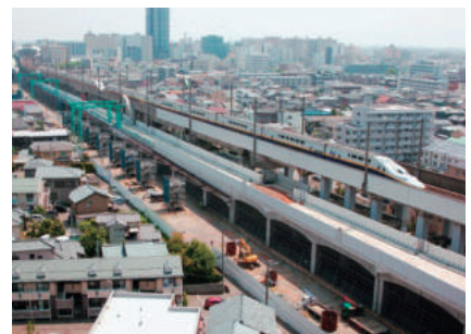
越後線の高架橋工事
