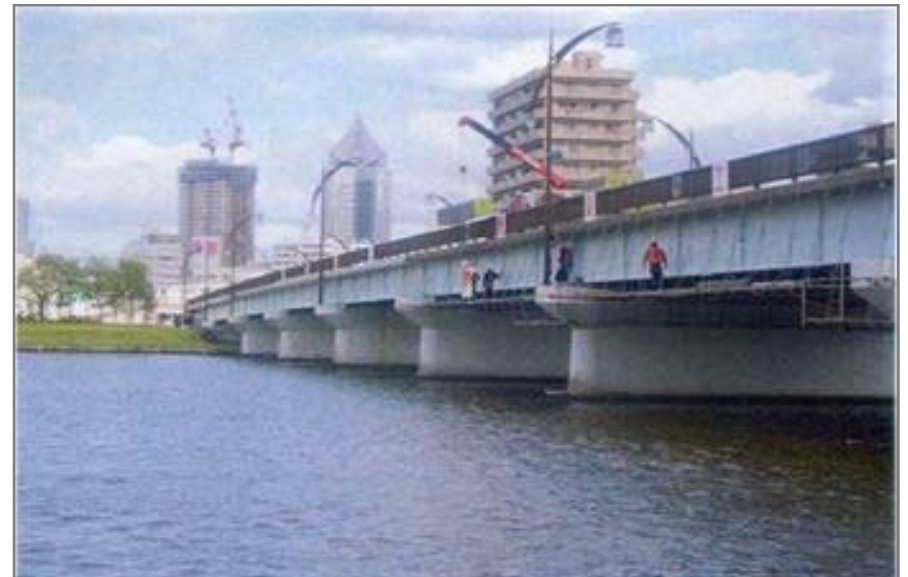
▲ 橋梁点検(八千代橋)
